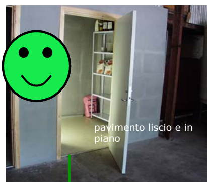
Fig. 28 – il locale per lo stoccaggio degli agrofarmaci deve essere dotato di pavimento liscio e non scivoloso.
