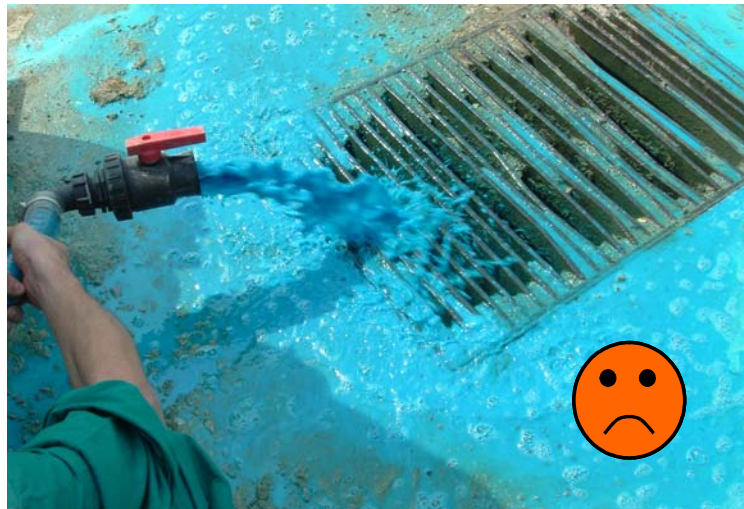
Fig. 104 - Esempio di NON corretto smaltimento della miscela residua e dell'acqua di lavaggio tramite tombino collegato alla rete fognaria.
