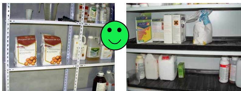
Fig. 21 - Usare scaffalature facilmente lavabili e ignifughe e prive di spigoli taglienti
